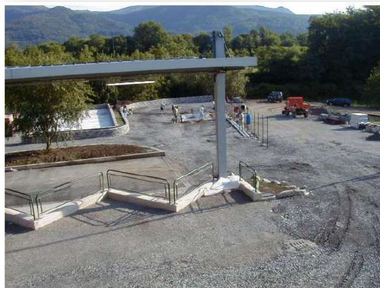
Figura 1 - La costruzione del centro di raccolta intercomunale di Tavernerio – anno 2001
